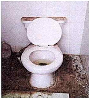
FOTO 5: SUSTITUCION DE INODOROS
